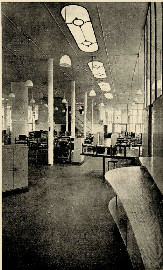
De centrale kantoornruimte in het gebouw
