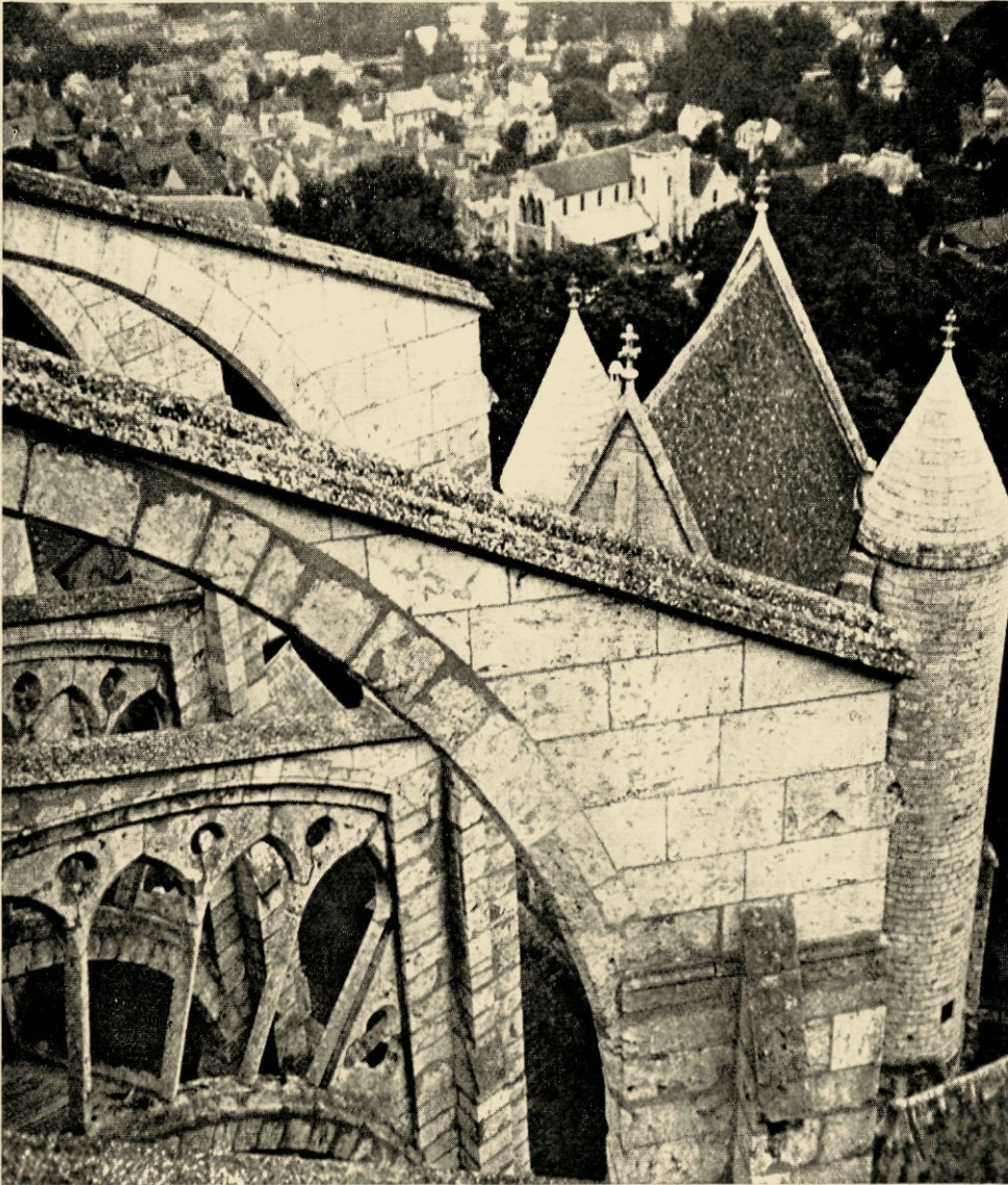
Chartres ter hoogte van het Koor - Zuidzijde - steunboogen van dakrand gezien. Op achtergrond de Romaansche kerk Saint André in restauratie
