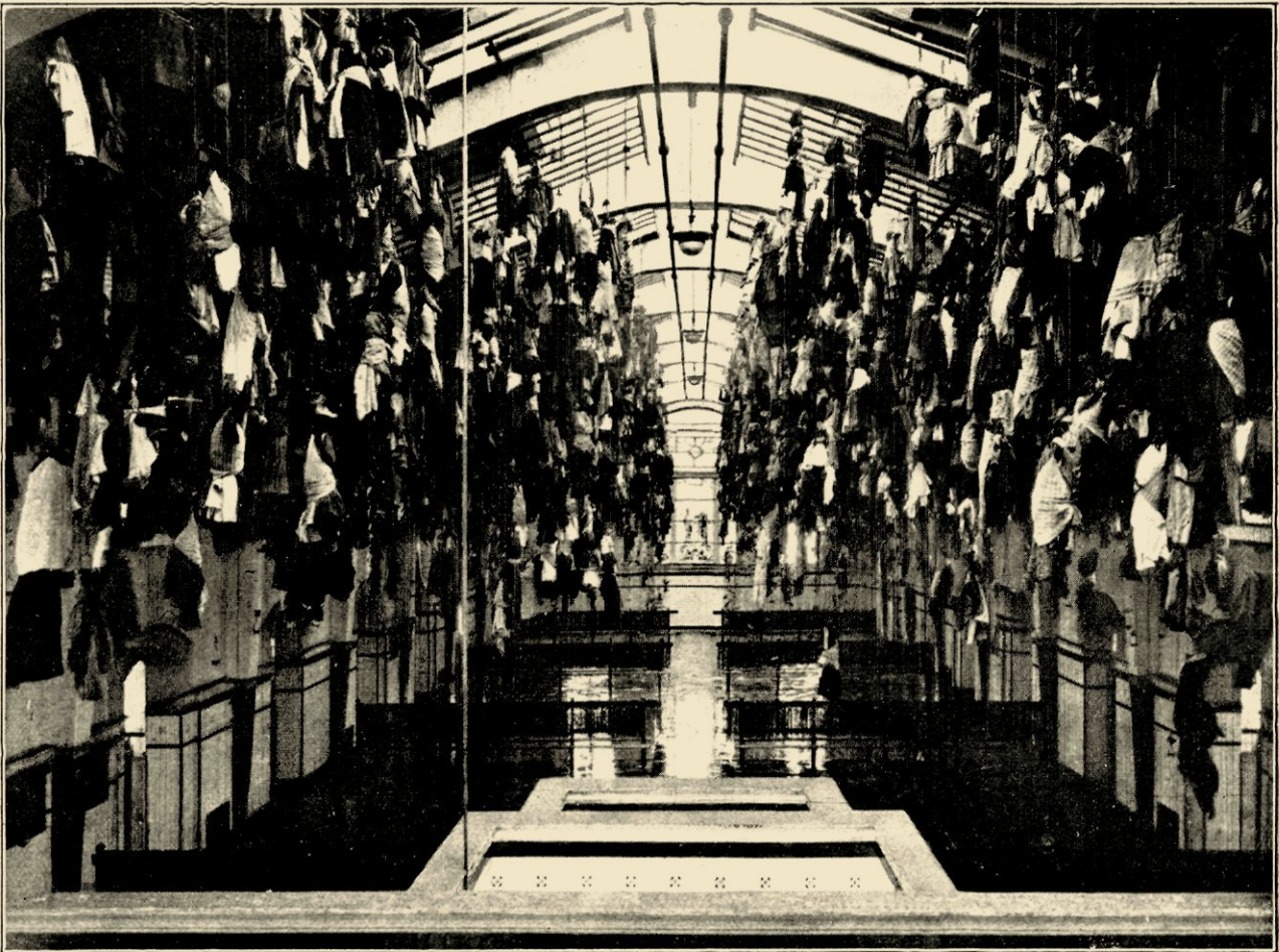
KLEEDRUIMTE IN HET BADGEBOUW VAN STAATSMIJN EMMA.
