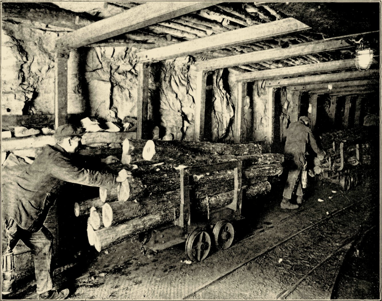
SLEEPERS VERVOEREN HOUT DOOR EEN MIJNGANG.
