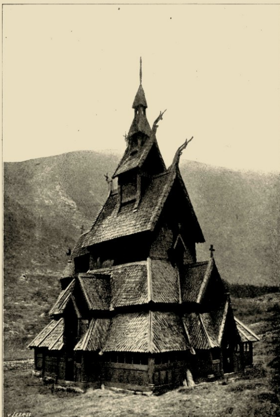
AFB. VII. STAVEKERK TE BORGUND.
