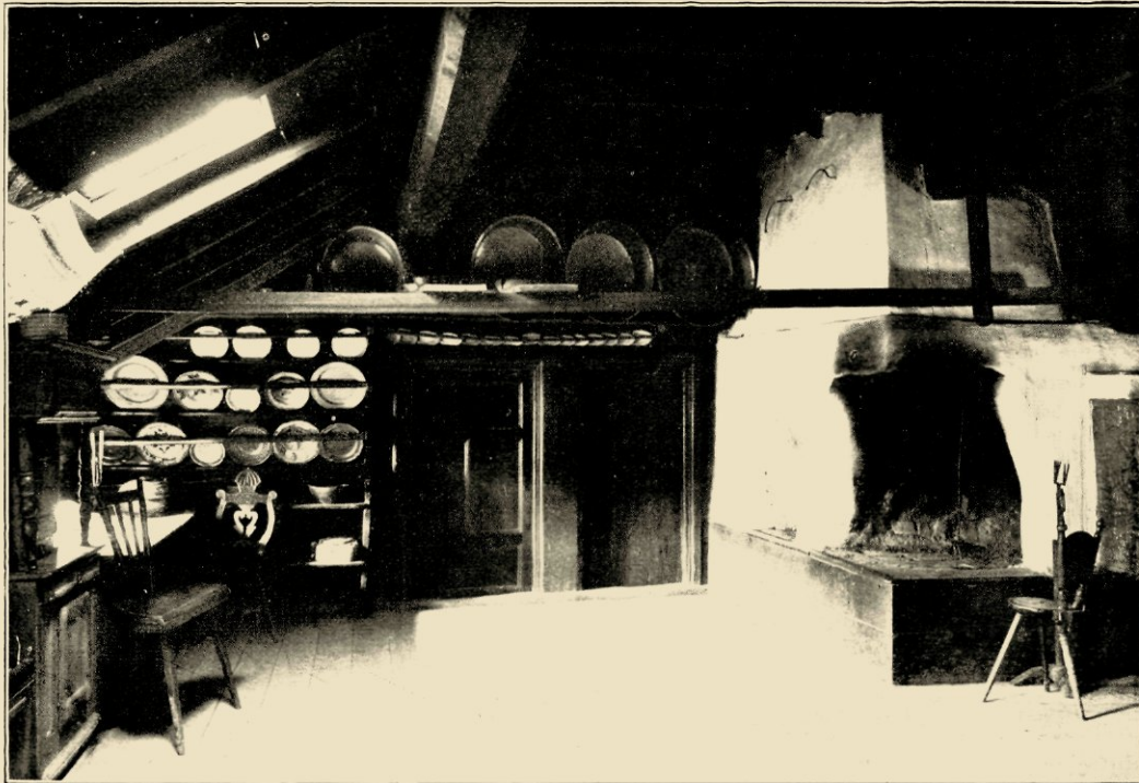
AFB. 13. DE GEMETSELDE HOEKHAARD IN HET HUIS UIT BLEKINJE, IN HET DAK LINKS GEVENSTERDE LJÖRE.
