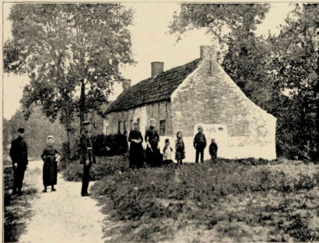
BETERE ARBEIDERSWONINGEN, VAN STEEN GEBOUWD, OOK ONDER JUBBEGA.
