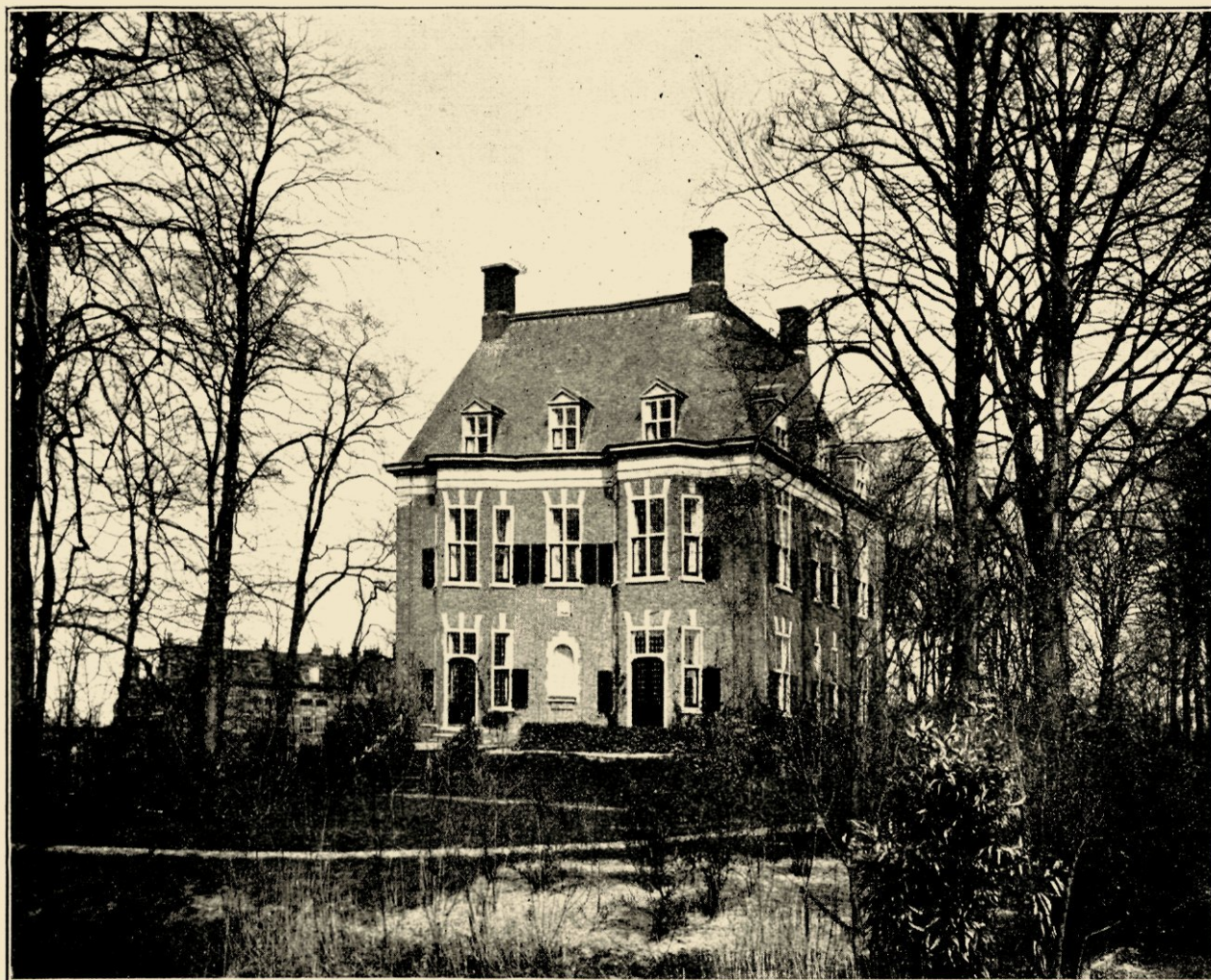
AFB. 5. ACHTERGEVEL VAN „'T HUIS VOORHOUT" TE ALKMAAR, GEB. IN 1906.
