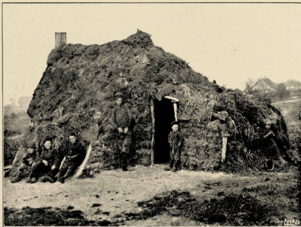
WONING VAN EEN BAGGERMAN ONDER JUBBEGA, Z.G.N. PLAGHUT.
